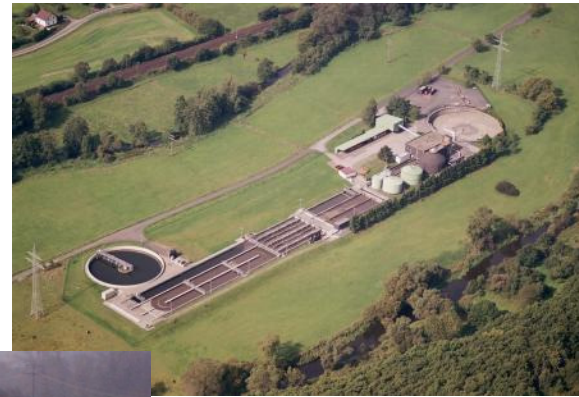
Kläranlage in Edingen
